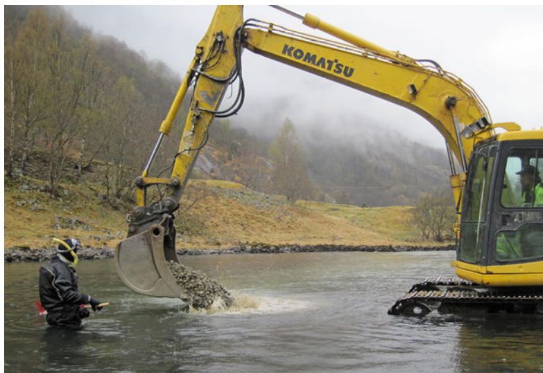
Figur 16. Fra utlegging av gytegrus med gravemaskin i Aurlandselva. Kvalifisert personell i snorkelutstyr angir plassering og mengde til maskinfører, og finfordeler grusen med rive/grafse. Foto: Bjørn Barlaup
