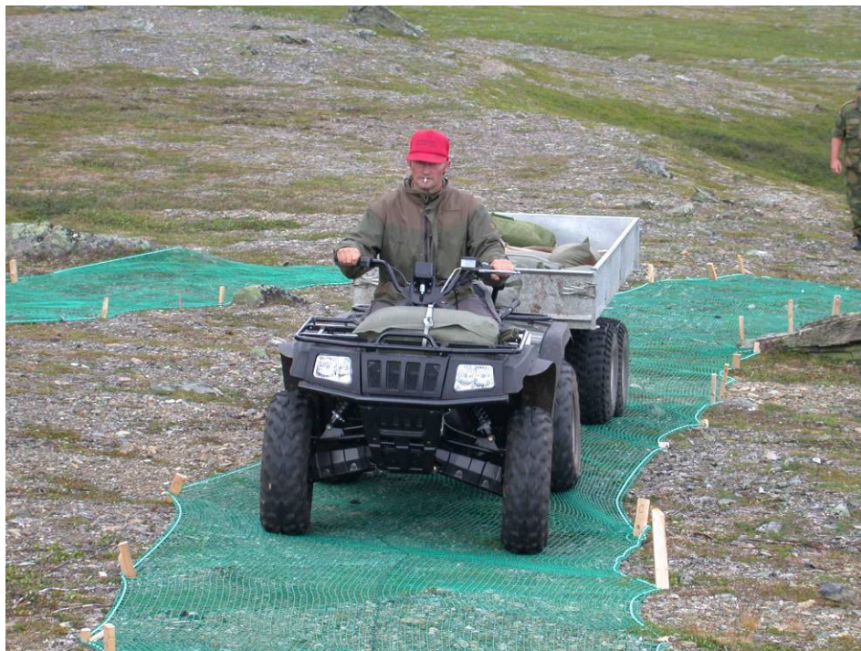
Det er gjennomført noen vellykka forsøk i Troms på kanalisering av ferdsel og forsterking av kjøretrasèar ved bruk av geo-nett og trålpopenett. Foto: H. Tømmervik.
