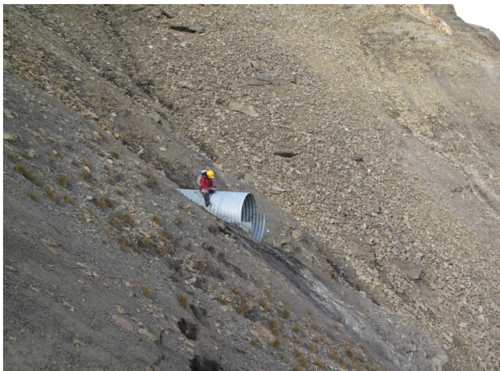
Figur 5.2. Nødutganger fra gruva vil påmonteres "svalbardrør" som gjennomføringsrør gjennom dagfjellsonen. Røret vil ha en diameter på ca 2 – 2,5 meter. Figuren viser et slikt gjennomføringsrør fra tidligere Svea Vest gruva (Foto: SNSG).
