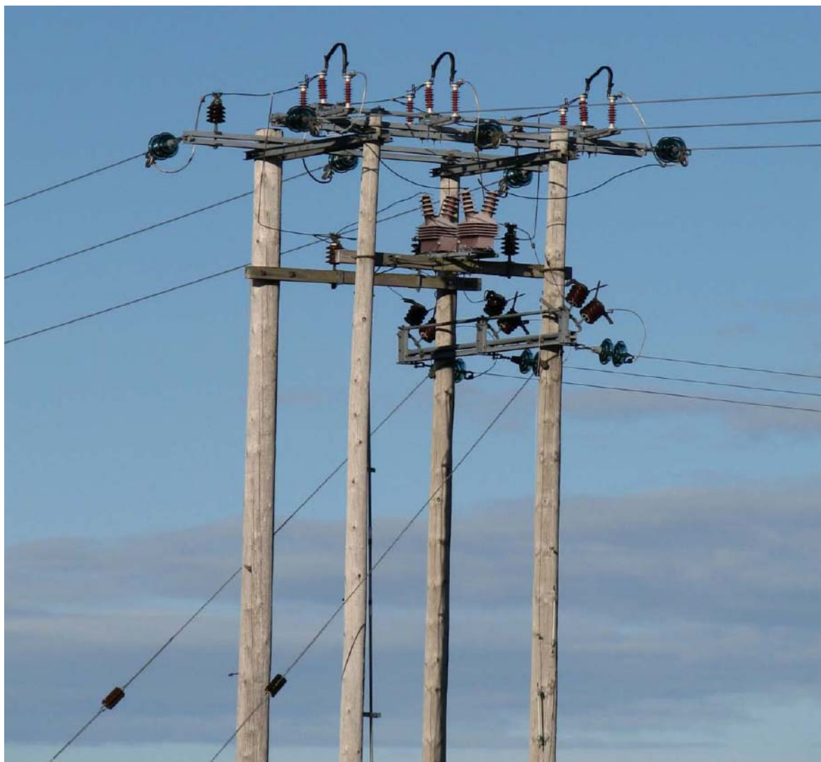
Figur 8. Avgreiningmaster er konstruert på mange måter. Ofte fremstår de som strukturer hvor fugler finner gode sitteplasser. I åpne landskap med lite skog blir derfor disse attraktive utkikksposter for fugler som ønsker å få oversikt og speide etter bytte. Det gjelder bl.a. rovfugl og måker. I kyststrøk, bl.a. på Smøla, er det dokumentert at slike konstruksjoner årlig tar livet av et betydelig antall havørn, kråkefugl og måker. De fortjener derfor med rette betegnelsen "killerpoles". Ved å utforme disse på en måte som reduserer attraktiviteten som sitteplass, samt isolere ledninger og traverser, vil dette problemet reduseres betydelig. Foto: Kjetil Bevanger.
