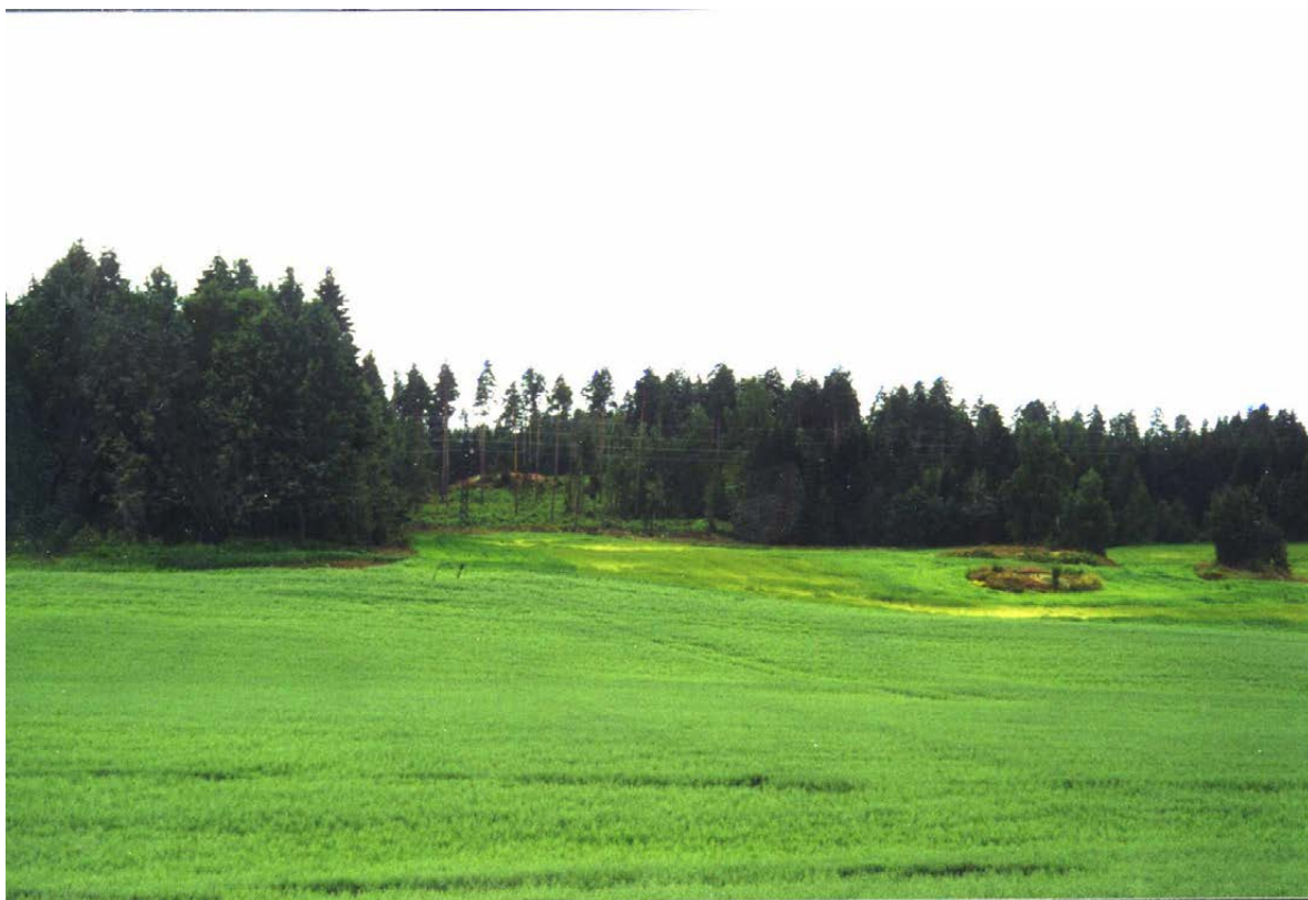
Figur 4. 50 kV ledning Enebakk-Flateby i Akershus. Syrebeiset line og brennlakkerte master. Både master og liner er vanskelig å få øye på med den mørke skogen som bakgrunn. Foto stilt til disposisjon av Akershus Nett AS.
