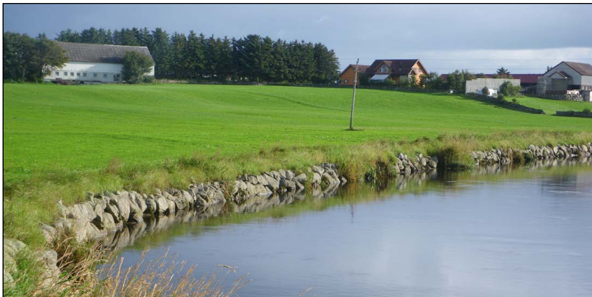
Steinsetting av elvebredden for å unngå graving og skade på dyrket mark, er vanlig langs store deler av Håelva mellom Nedre Haugland og Hå. Foto: Bjørn Mejdell Larsen.
