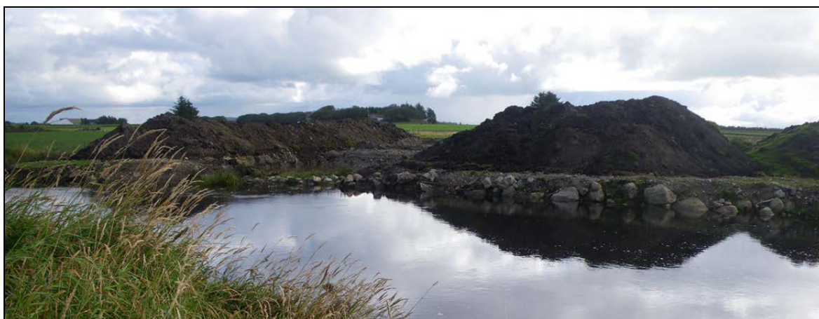
Åpne jorddeponier, om enn midlertidige, kan gi høy avrenning av finpartikulært materiale mot vassdraget i perioder med mye nedbør og høy vannføring. Foto: Bjørn Mejdell Larsen.
