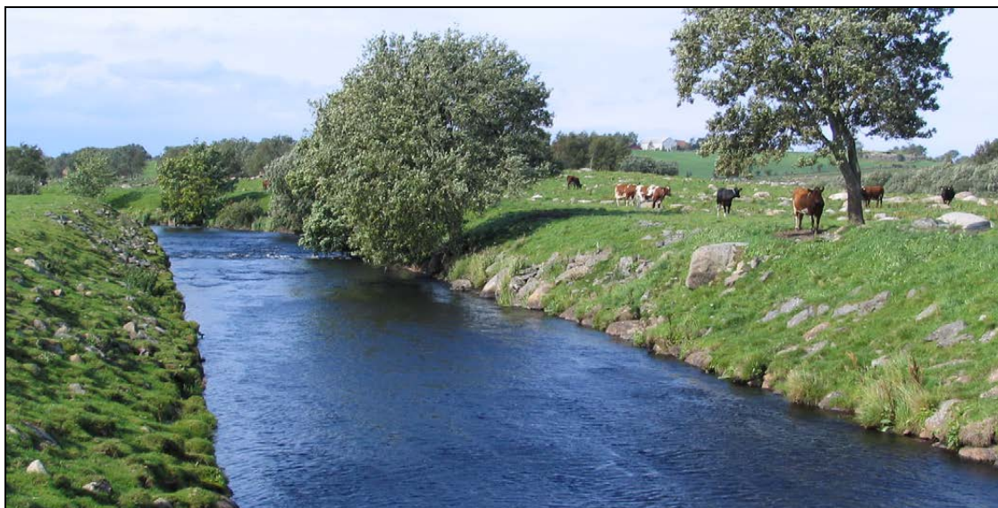
Håelva har flere steder et utpreget kanalisert preg med rette elvekanter og bratte sider. Dette gjør vassdraget lite dynamisk, og resulterer i høy vannhastighet når vannføringen øker. Foto: Bjørn Mejdell Larsen.
